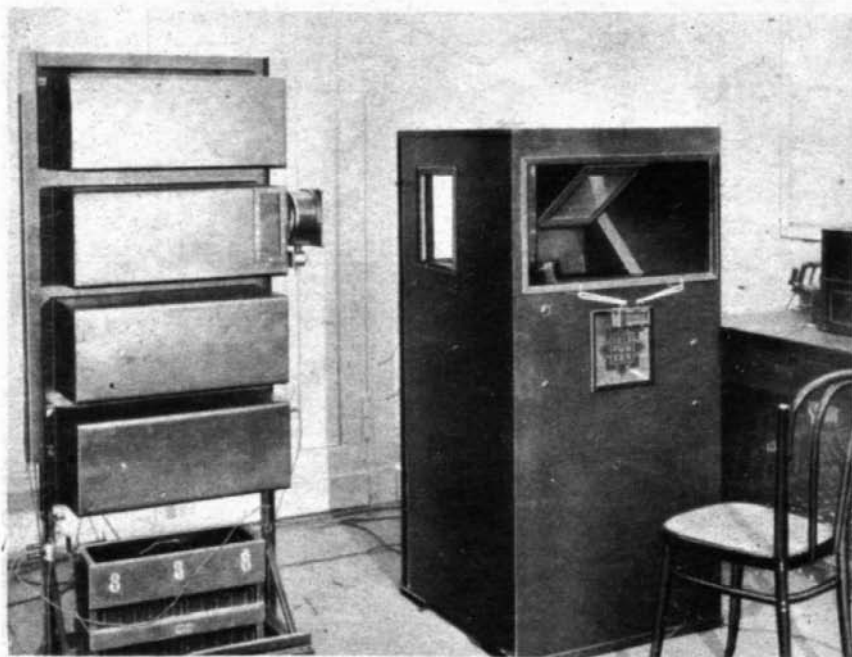
Die komplette Sendeapparatur des Fernsehers, die man bei jedem Rundfunksender zur Aufstellung bringen kann. Links das Verstärkergestell,
